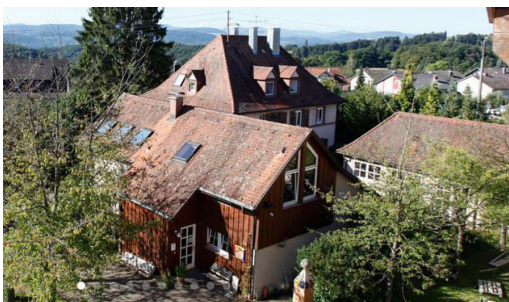
Abbildung 1: Batiments du Rehazentrum:
